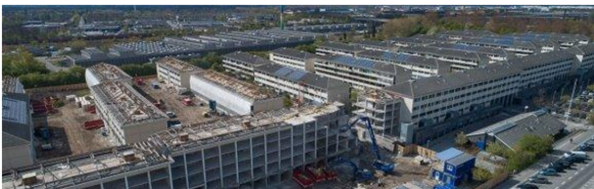
Demolition of Taastrupgård
